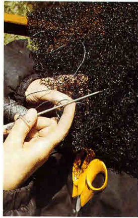
Det bedste er at bruge Enkamaten i et sammenhængende stykke. Ved en eventuel samling skal det sammensynes.
