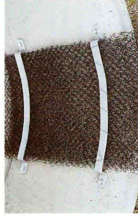
Enkammatmåtte fastgjort i betonrør f.eks. ved rørunderføringer.
