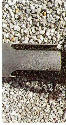
Opslidset plastrør gør det muligt for ålene at komme ind i passet.
