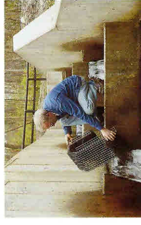
Enkammatmåtte fastgjort i betonrør f.eks. ved rørunderføringer.
