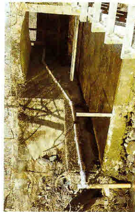
Ålepasset kan føres uden om stemmeværkets bevægelige dele, her er det monteret fast på betonvæggen.
