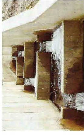
Fiske-trapper er ikke passable for ål, og skal derfor være forsynet med ålepas.
