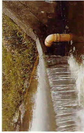
Ålepasset er her indstøbt i styrtets betonvæg, og videreført et stykke opstrøms.
