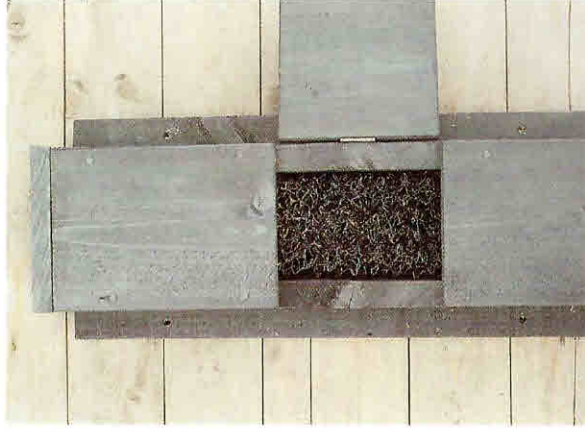
Mange ålepas er indlagt i en trækasse, og så denne form skal forsynes med en inspektionslem.
