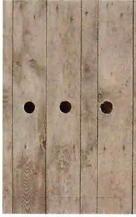
Gennembores i styrtvæggen (min. 50 mm huller).
