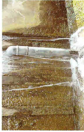
Ålepas ført frem i plastør, opslidset i bunden og forsynet med inspektionslem.
