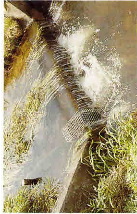
Ålepasset er her indstøbt i styrtets betonvæg, og videreført et stykke opstrøms.
