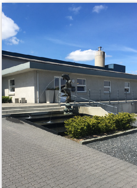
Renovering og udbygning af administrationen i Give.
