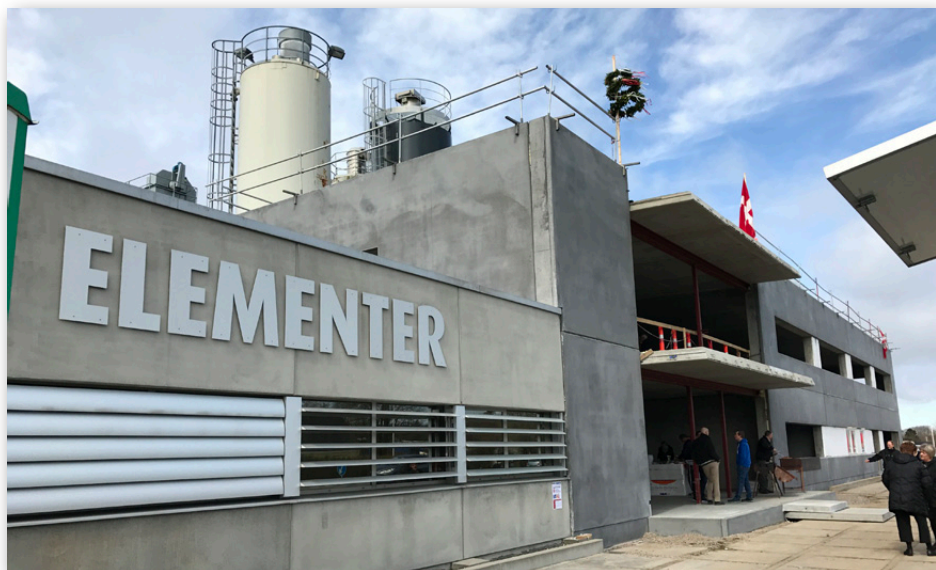
Den nye administrationsbygning i Nr. Snede.
