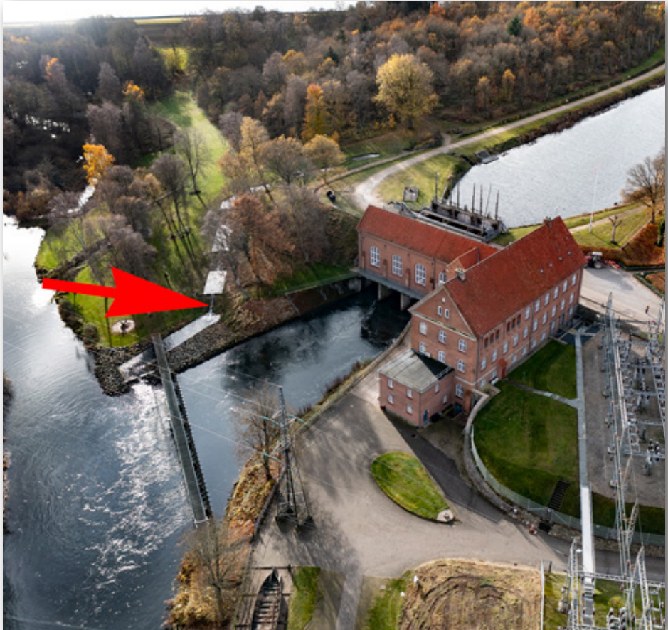
Tangeværket ligger i Gudenåens hovedløb, opstemningen er 10 m høj og hindrer fri faunapassage både for op- og nedstrøms vandrende fiskearter. Pilen (rød) viser den nuværende fisketrappe, som ikke tilgodeser vandrefiskenes behov for op- og nedstrøms passage.
