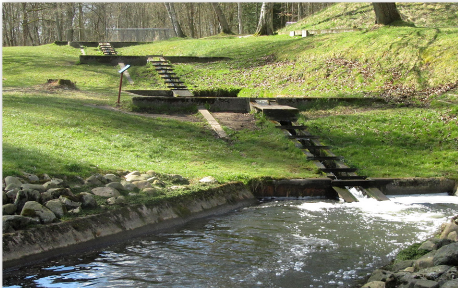
På trods af en fisketrappe fungerer Tangeværket reelt som en prop i Gudenåen. Foto: Nico-dk, WikiCommons
