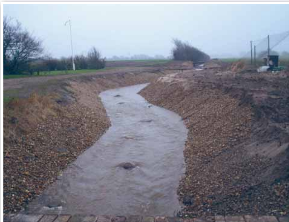
Her var der tidligere et stemmeværk – nu har fiskene fået fri passage.
